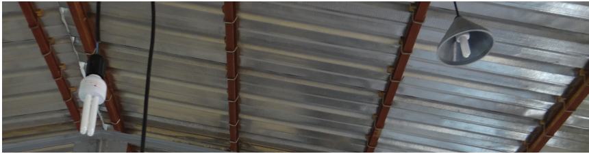
Abbildung 4: Dargestellt ist die verwendete CFL-Art sowohl mit als auch ohne Lampenschirm. Solche oder ähnliche Lampenschirme aus dunklem Plastik sollten nicht weiter benutzt werden, da sie die Ausleuchtung verschlechtern.
